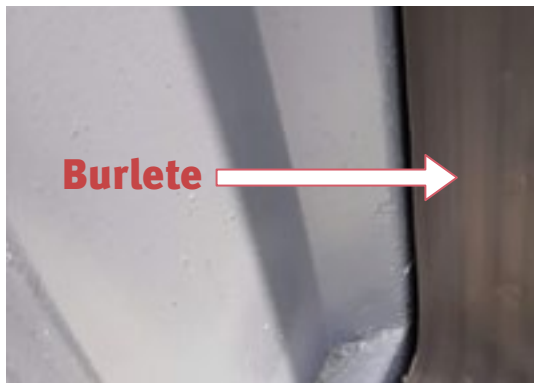
Figura 7: Puertas hermetizadas con burletes, flejes o tiras de sellado
