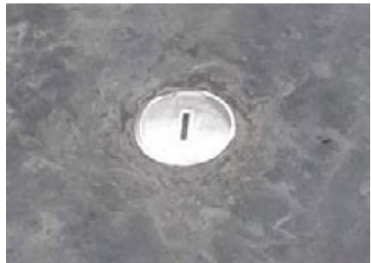
Figura 38: Registro de desagüe
