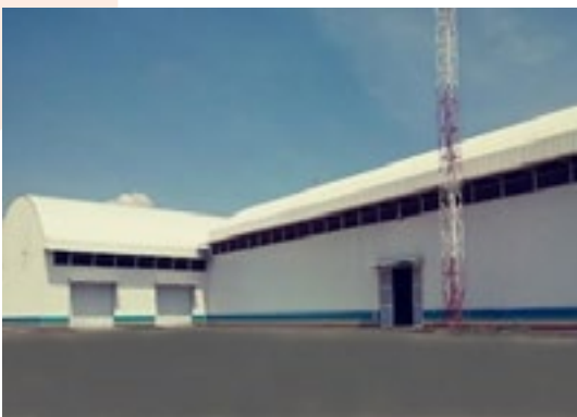
Figura 2: Accesos a una fábrica pavimentados
