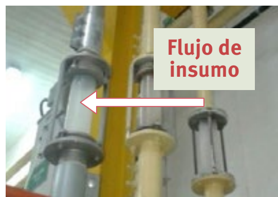
Figura 19: Transporte neumático de insumos a granel
