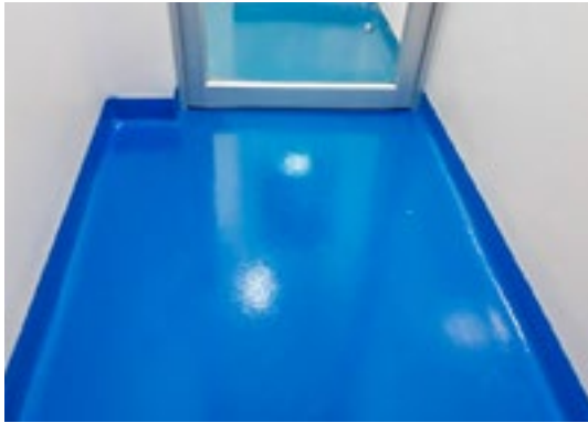
Figura 4: Pisos lisos y sin grietas y unión piso-pared a media caña
