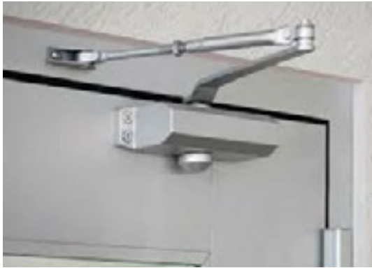
Figura 23: Brazo hidráulico para mantener la puerta cerrada
